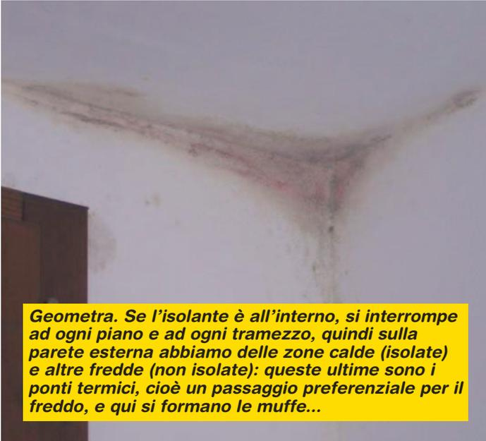
**Geometra.** Se l'isolante è all'interno, si interrompe ad ogni piano e ad ogni tramezzo, quindi sulla parete esterna abbiamo delle zone calde (isolate) e altre fredde (non isolate): queste ultime sono i ponti termici, cioè un passaggio preferenziale per il freddo, e qui si formano le muffe...
