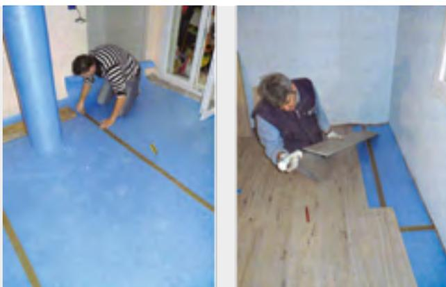
^ Figura 2 - Posa dello strato acustico anticalpestio e del pavimento flottante.
