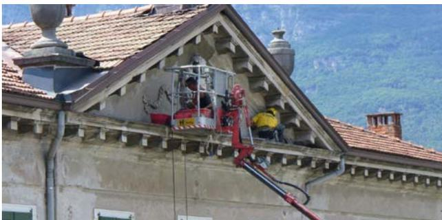
^ *Cantiere anno 2016 a Rovereto. È evidente la mancata programmazione dell'attività, l'assenza di vigilanza da parte del datore di lavoro o sorveglianza da parte del preposto. L'assenza di alcuna valutazione del rischio da parte dei lavoratori.*
